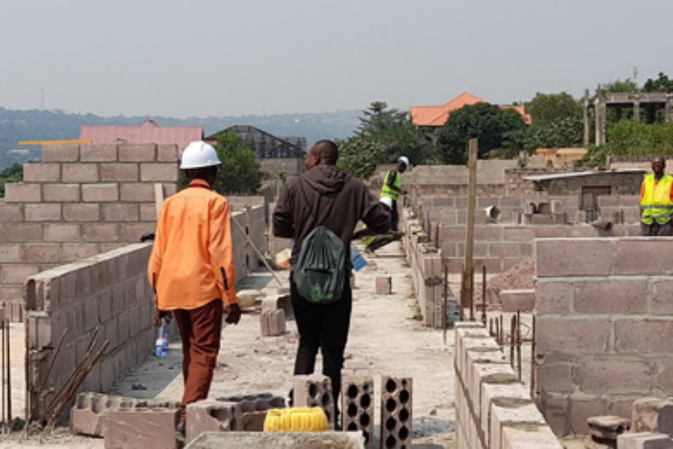
> Construcción escuela secundaria Kinshasa (RDC)
